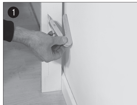
1 Justeringen anpassad till väggens förspänning så att den yttre gaveln kan monteras i bulk
